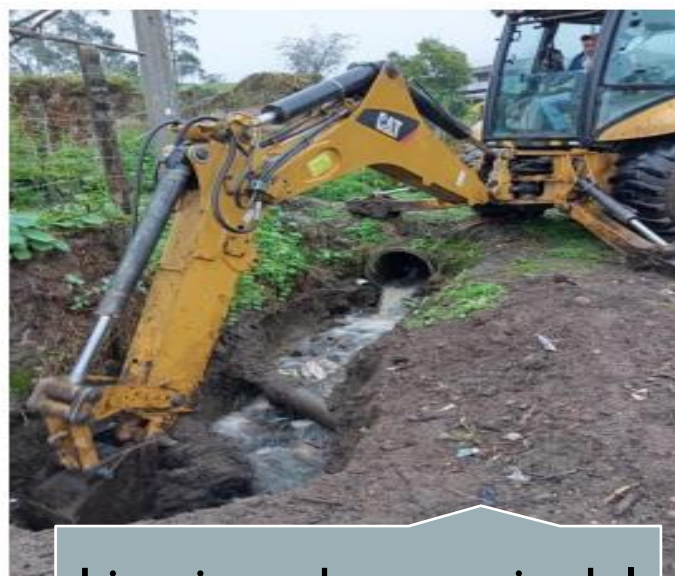
Limpieza de acequia del barrio Guanguibana
