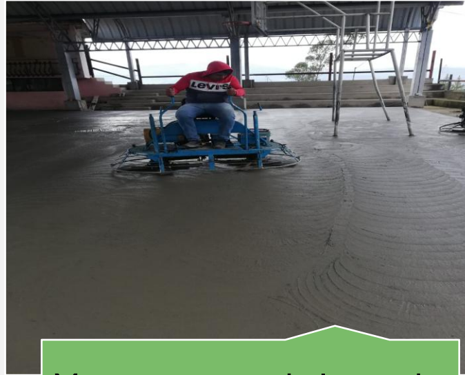
Mantenimiento de la cancha con malla electro soldada
