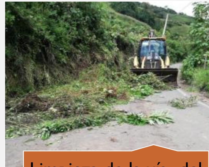
Limpieza de la vía del barrio Tasinteo
