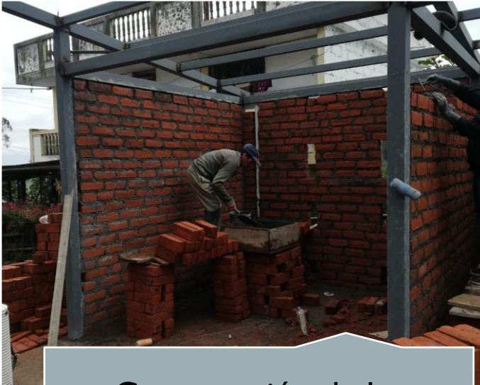
Construcción de las baterías sanitarias
