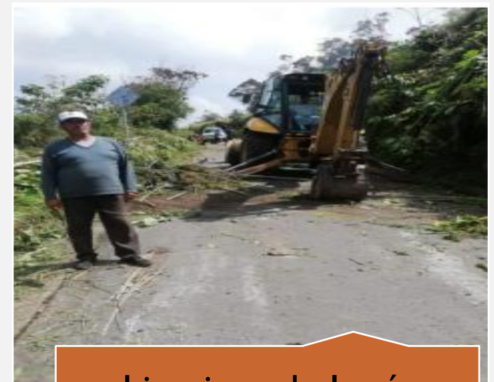
Limpieza de la vía Tasinteo
