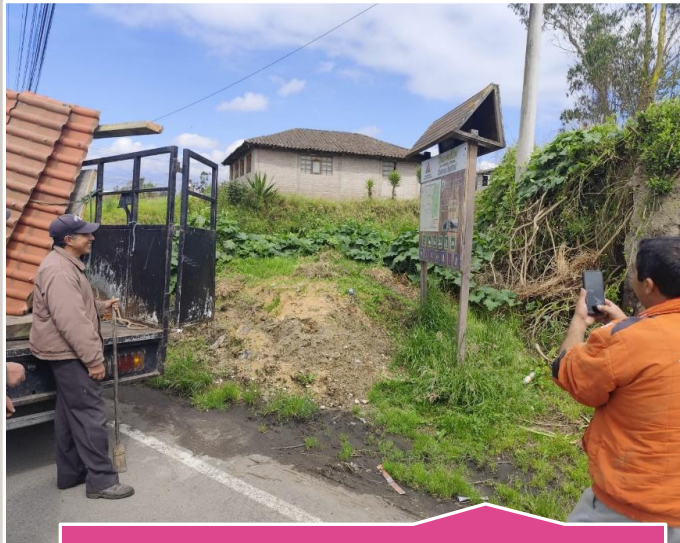
Desmontaje de paneles
