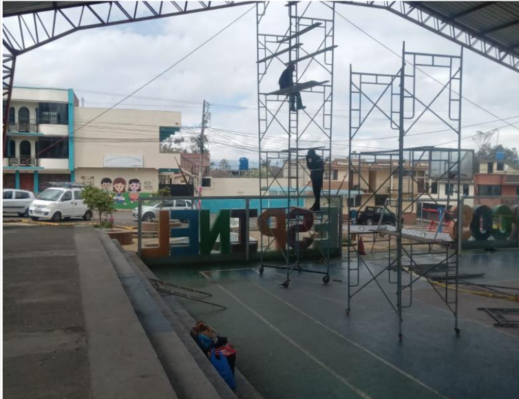
SUMINISTRO E INSTALACION DE LAS DERIVACIONES SECUNDARIOS
