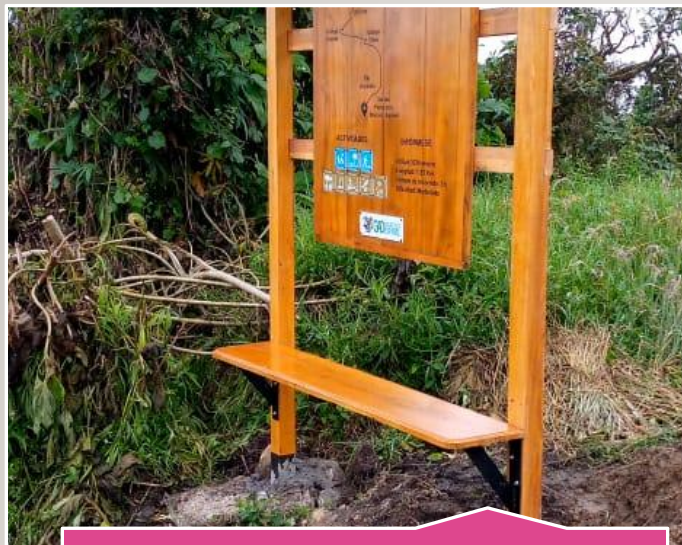
Instalación de Paneles
