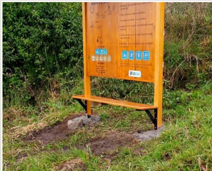
Instalación de Paneles
